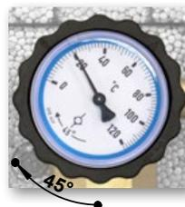
Pour vidanger le circuit, il faut exclure le clapet anti retour en tournant le volant avec thermomètre bleue de 45° dans le sens des aiguilles d'une montre, en partant de la position de complète ouverture (voir illustration à côté).
