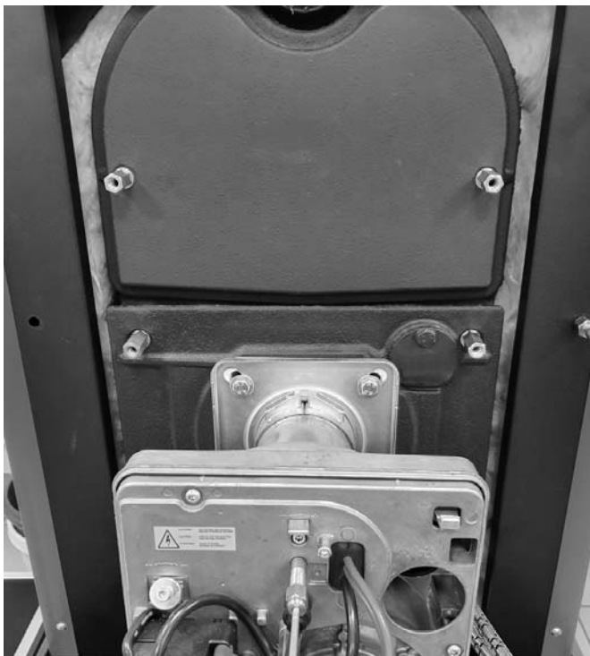
Abb. 84: Obere und untere Kesseltür
