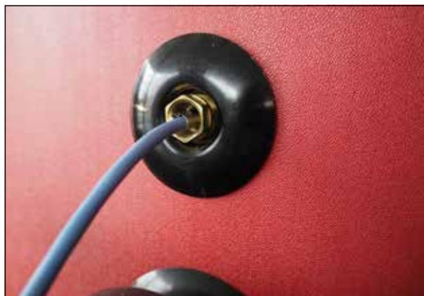
Der Temperaturfühler PF im unteren Bereich des Pufferspeichers, der in der Hülse möglichst tief eingeführt ist.
