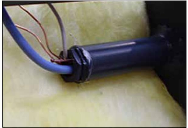
Der Kesseltemperaturfühler WF ist in einer Hülse am Kesselkörper angebracht. Der Fühler ist den anderen Kapillaren von Thermostaten und Thermometern der ursprünglichen elektromechanischen Kesselregelung hinzugefügt.
