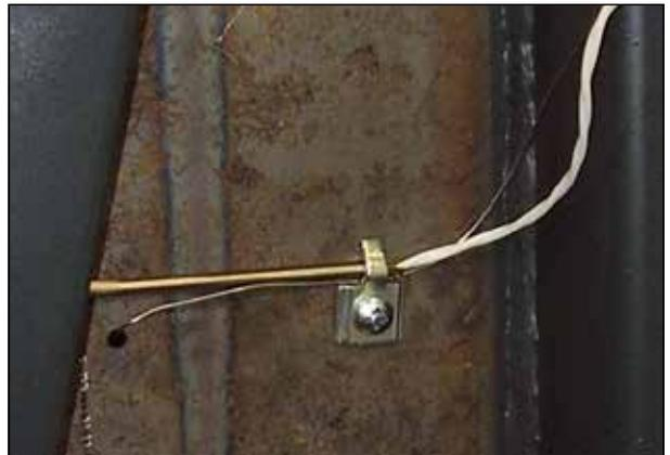
Der Abgasfühler AGF anliegend an der Abgasleitung des Kessels (DCxxS, DCxxSX, DCxxGS, CxxS(T)). Der Fühler ist der Kapillare des Abgastermostats von der ursprünglichen elektromechanischen Kesselregelung hinzugefügt.
