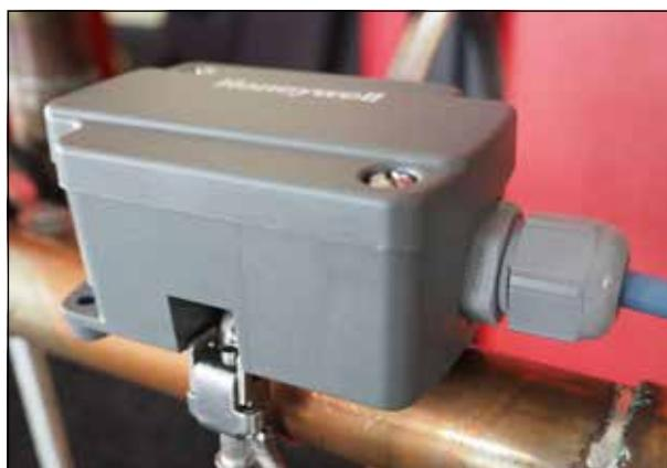
Der anliegende Fühler hinter dem Mischventil, der die Wassertemperatur im Heizkreis erfasst.
