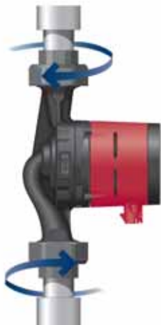
Abb. 1 Montage der ALPHA2/ALPHA3
