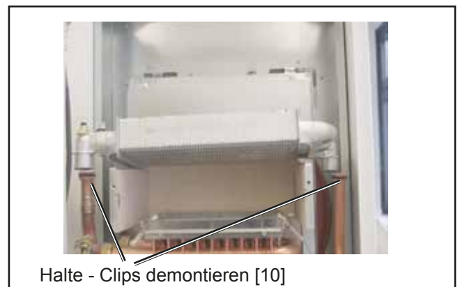
Bild: Demontage Heizwasserwärmetauscher
