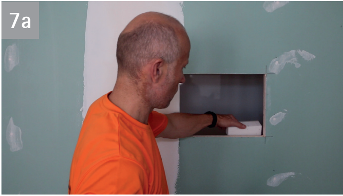
7a Bei großen Toleranzen des Ausschnittes können die Montageklötze zusätzlich montiert werden!
