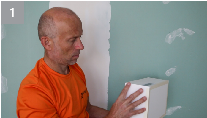
1 Sichtkontrolle auf Beschädigung
