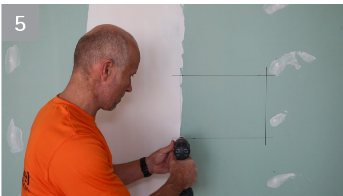
5 Löcher innerhalb der Ecken bohren
