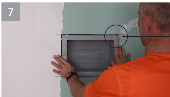
7 Grundkörper in Wand einfügen
