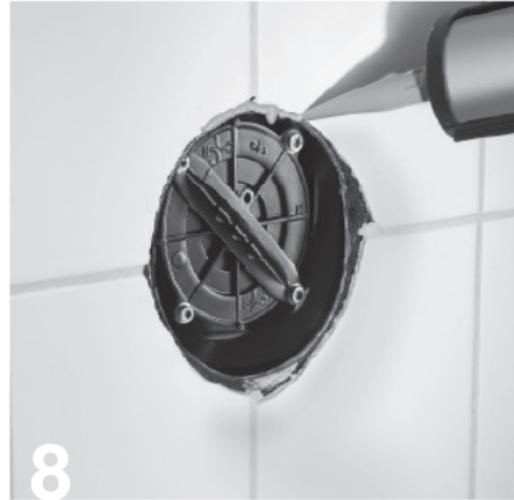
1. Bei der Montage der beigefügten Gewindenippel muss der Gummi-kragen pressend an der Box anliegen. Wie üblich müssen die Nippel mit Dichtmaterial versehen werden.
