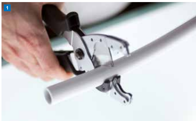
Rohr abschneiden Zunächst wird das Rohr mit dem Uponor Rohrschneider rechtwinklig abgeschnitten.
