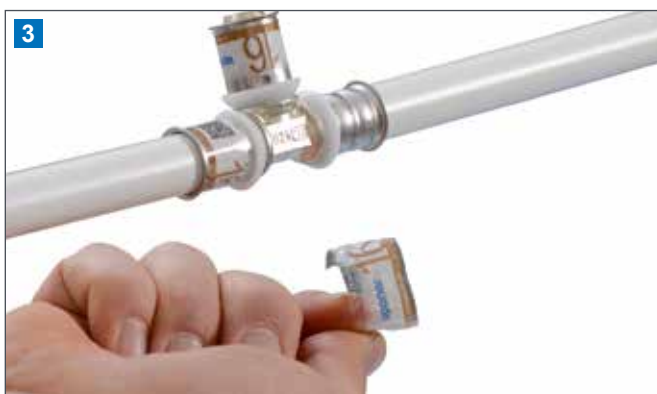
3 Nach dem Verpressen ist eine deutliche Verformung der Edelstahl-Presshülse sichtbar. Außerdem lässt sich die Folie nach erfolgreicher Verpressung einfach ablösen (Sichtkontrolle).
