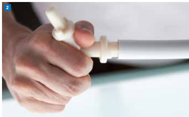
Kalibrieren Vor der Fittingmontage wird das Rohrende kalibriert.
