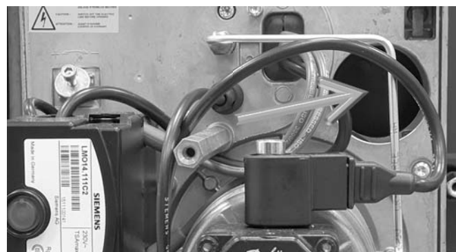
Abb. 9: Luft-Ansaugöffnung des Blau-Brenners BNR
