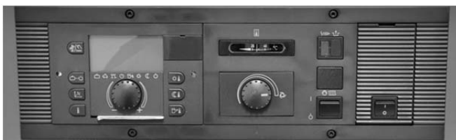
Abb. 35: Montierte THETA+ im Kessel-Grundschaftfeld.
