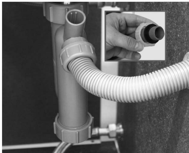
Abb. 16: Montage des Kondensatschlauchs
