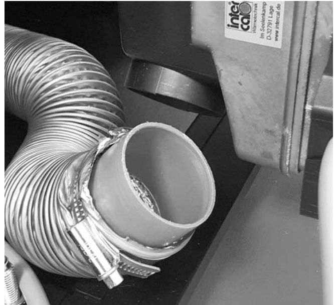
Abb. 13: Zuluftschlauch mit 50 mm Anschluss-Stück
