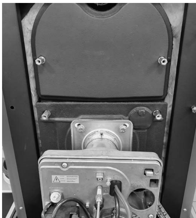
Abb. 84: Obere und untere Kesseltür
