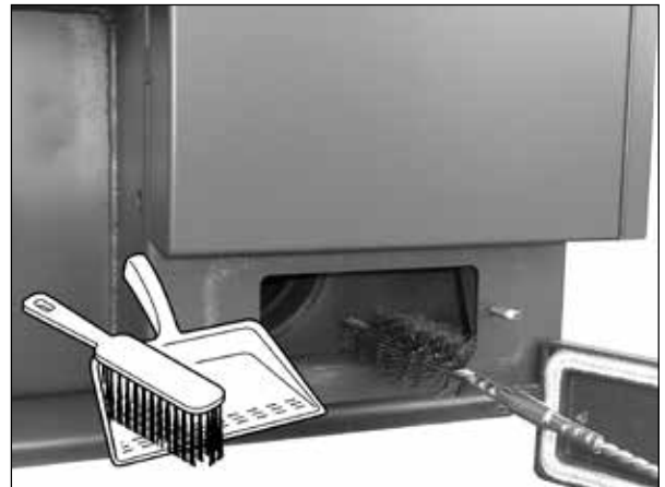
Vorführung der Reinigung des Rauchkanals mit Drahtbürste.
