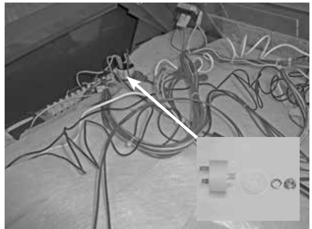
Kondensator für Abzugventilator - 1µF
