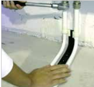
Die Rohrleitungen in den Winkel-Profi einclippen und die Verschraubungen am Hanhblock anziehen.
