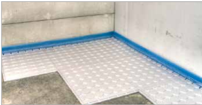
Profilplatte in einer Raumecke beginnend fugendicht unter die Folienschürze des Randdämmstreifens verlegen.
