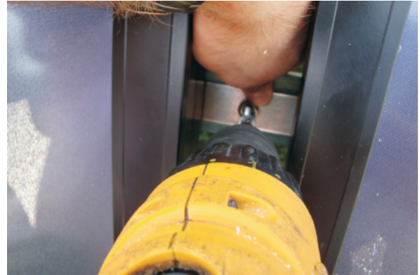
Die Platte auf die Dachlatte festschrauben.
