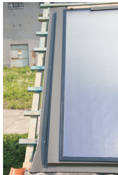
Seitliche Rinne befestigen und maskier leiste einschieben .
