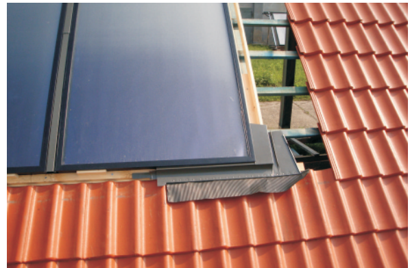
Verblechung in die Vorbereiteten einschneidungen einführen.
