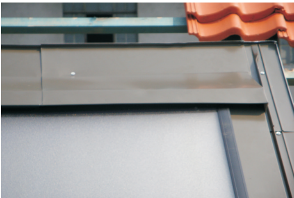
Mittlere Maskier Leisten fest einschrauben.
