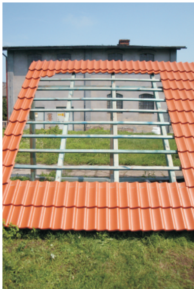
Entfernen der Dachziegel an den entsprechenden Stelle.
