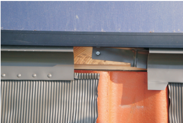
Untere Verblechung Platzieren und befestigen.
