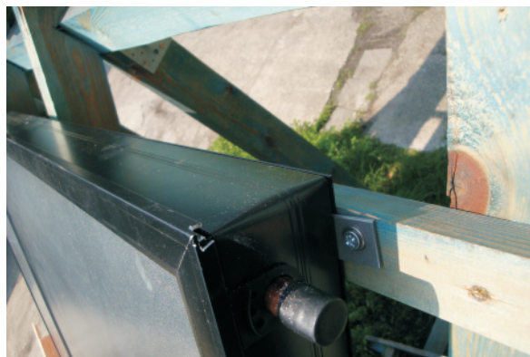
Außen die kleinen Verbindungs platten festschrauben.
