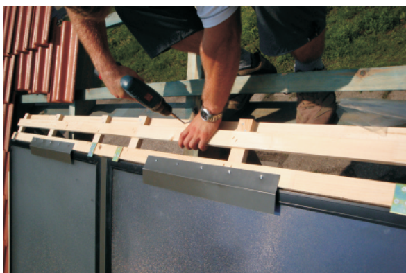
Oberes Brett platzieren und festschrauben.
