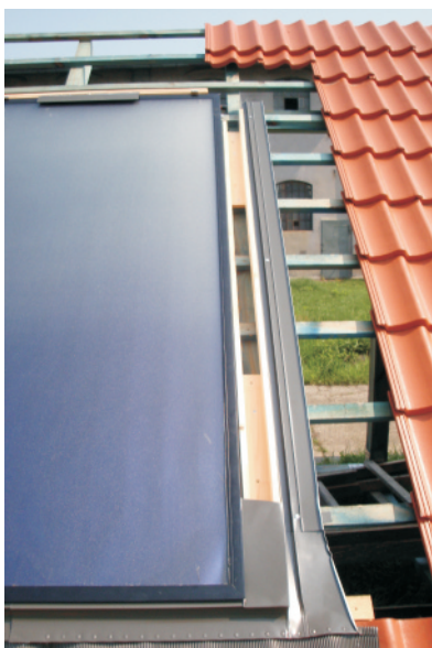
Seitliche Rinne befestigen und maskier leiste einschieben .
