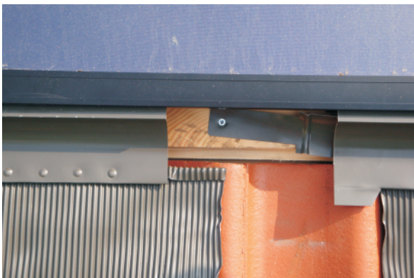
Untere Verblechung Platzieren und befestigen.
