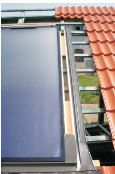
Seitliche Rinne befestigen und maskier leiste einschieben .
