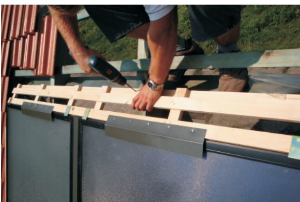
Oberes Brett platzieren und festschrauben.
