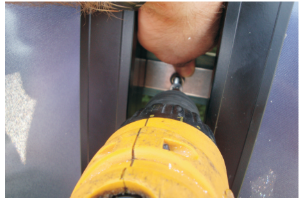
Die Platte auf die Dachlatte festschrauben.
