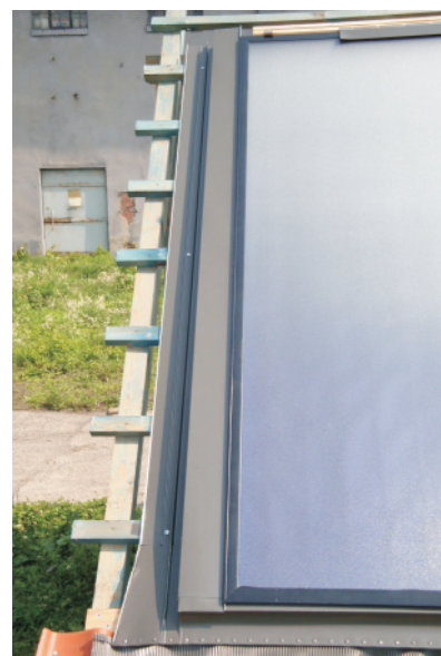
Seitliche Rinne befestigen und maskier leiste einschieben .
