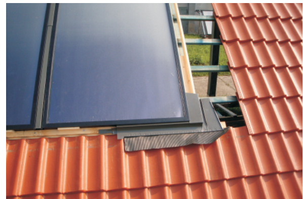
Verblechung in die Vorbereiteten einschneidungen einführen.
