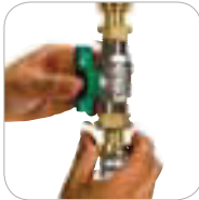
1. Lösen der Verschraubungen
