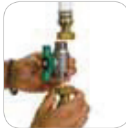
3. Einsetzen des neuen Kugelhahns
