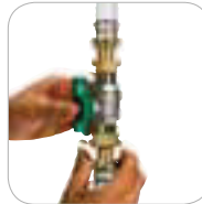
4. Festziehen der Verschraubungen
