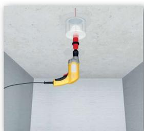
**2** Mit einem Lochsneider wird die individuelle Öffnung ausgebohrt ...
