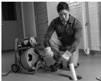
Slika 10 – Primer produženog odvoda na otvoru sajle u granicama od 2' (0,6 m)
