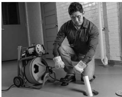
Obrázek 10 – Příklad prodloužení odpadu tak, aby byl max. 2' (0,6 m) od vývodu spirály
