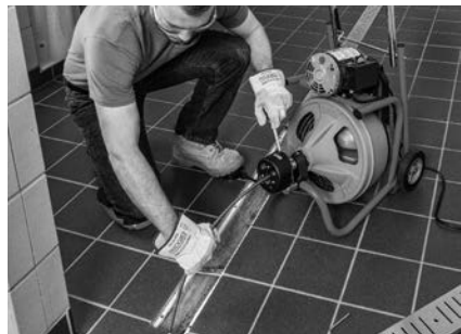
Figure 15 – Utilisation du K-400 avec AUTOFEED
