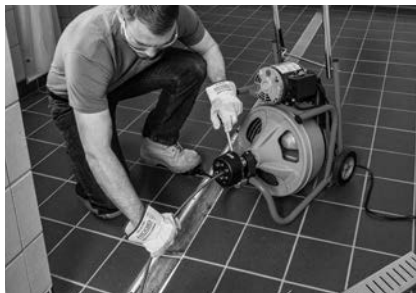
Kuva 15 – K-400-laitteen käyttö AUTOFEED-syötön kanssa.
