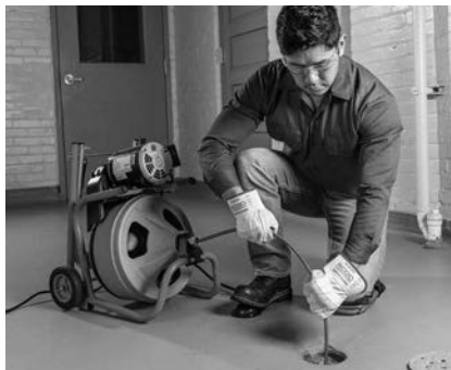
Рис. 13 – В рабочем положении, ручная подача троса
