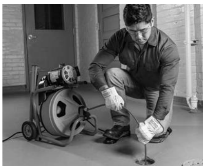
Slika 13 – U poziciji za rad, ručno uvlačenje sajle
