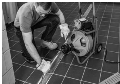
Рис. 15 – Эксплуатация модели K-400 с механизмом автоподачи AUTOFEED
