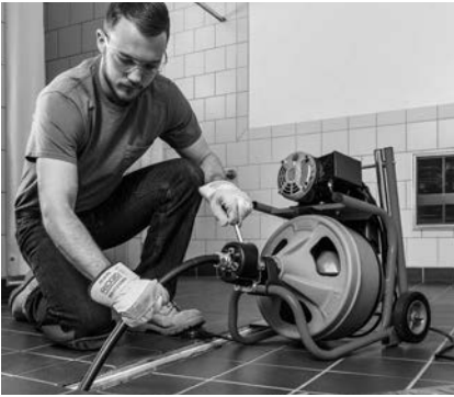
Figuur 16 – Machine gebruiken met geleidingslang
