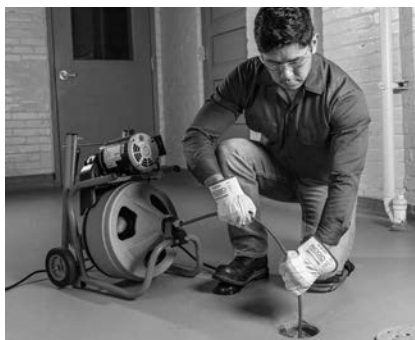
Rys. 13 – Ręczne wprowadzanie sprężyny w położeniu obsługi
