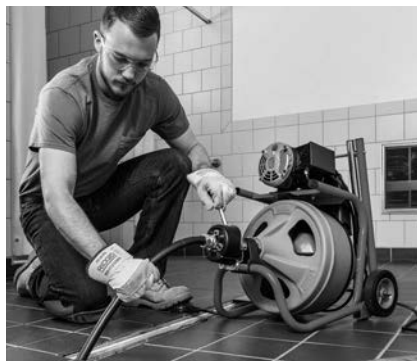
Рис. 16 – Использование машины с направляющим шлангом
