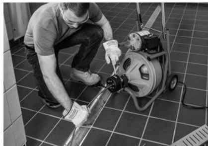
Abbildung 15 – Operating K-400 mit AUTOFEED Vorrichtung
