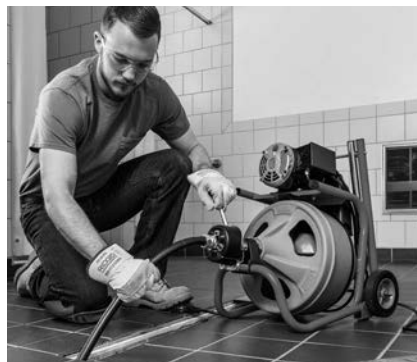
Slika 16 – Korištenje uređaja s vodicom crijeva
