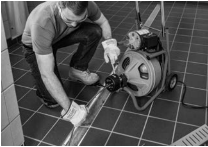
Figur 15 – Använda K-400 med AUTOFEED
