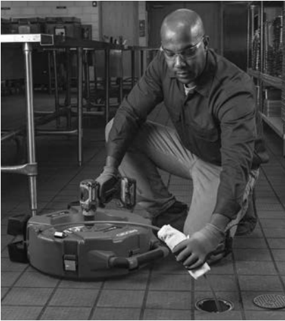
Figur 13 - Påføring av smøremiddel på kabelmantelen
