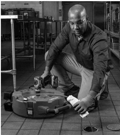
Abbildung 13 – Auftragen von Schmiermittel auf die Spiraleummantelung
