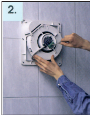
Bild 10: Elektroanschluss der VENTO.TRONIK®
