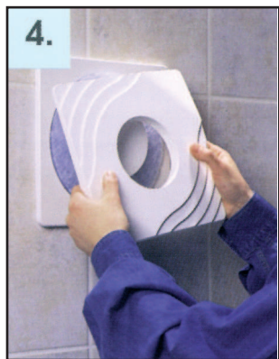
Bild 6: Aufstecken der Lüfterfassade
