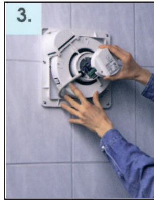
Bild 11: Aufstecken der VENTO.TRONIK®
