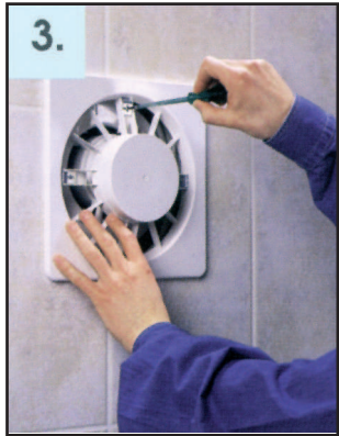
Bild 5: Montage des Filterträgers
