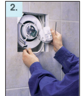
Bild 4: Elektro-Anschluss der VENTO.TRONIK®
