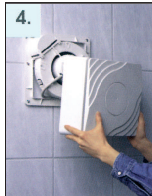
Bild 12: Aufstecken der Lüfterabdeckung
