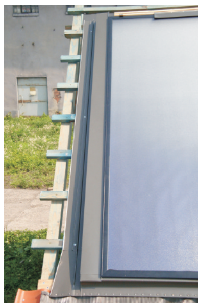
Seitliche Rinne befestigen und maskier leiste einschieben .
