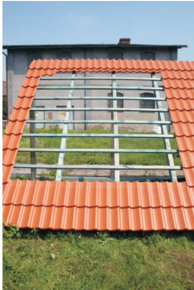
Entfernen der Dachziegel an den entsprechenden Stelle.
