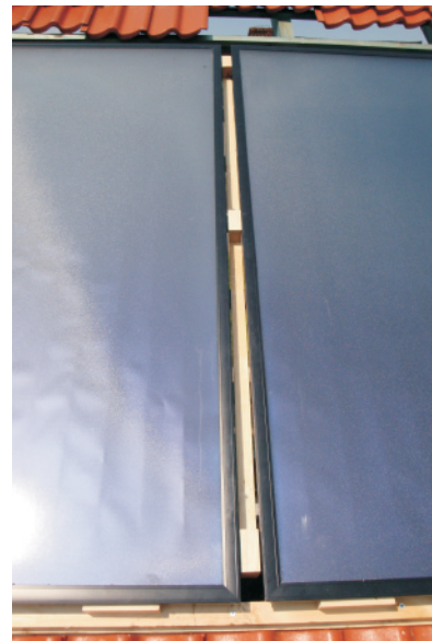
Mittleres Holz platzieren und festschrauben.
