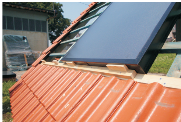
Den ersten Kollektor auf den unteren Brett platzieren.
