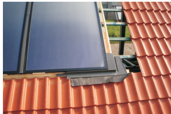
Verblechung in die Vorbereiteten einschneidungen einführen.
