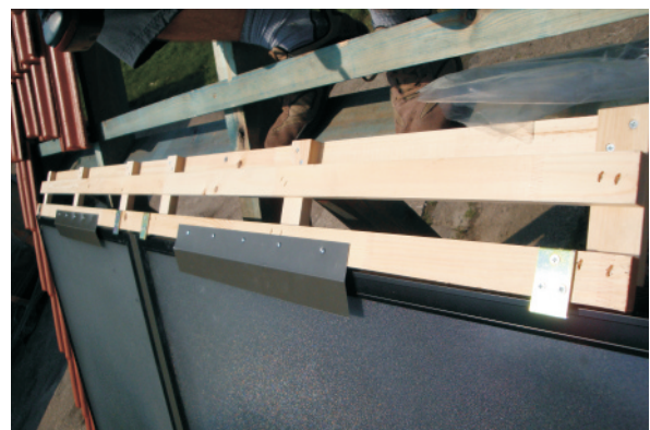
Mittleres Holz platzieren und festschrauben.
