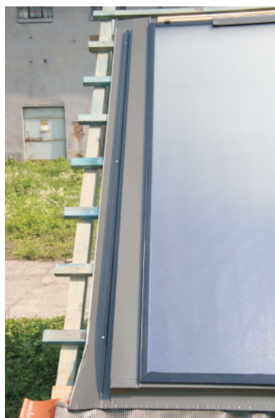
Seitliche Rinne befestigen und maskier leiste einschieben .
