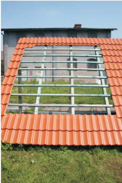
Entfernen der Dachziegel an den entsprechenden Stelle.
