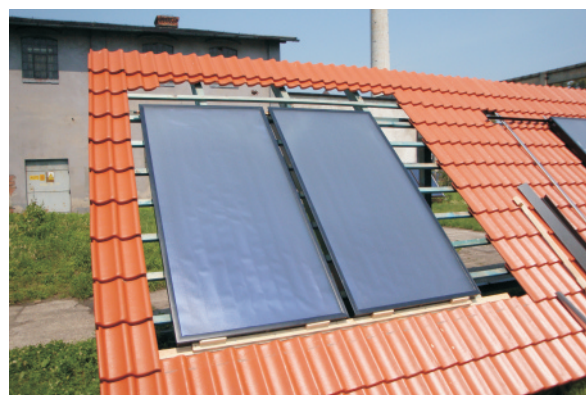
Dann den zweiten Kollektor auf den unteren Brett platzieren.
