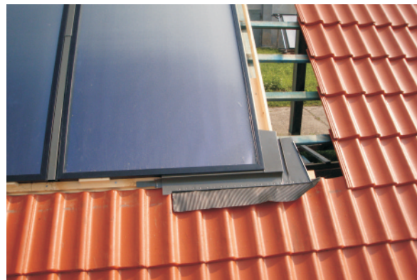
Verblechung in die Vorbereiteten einschneidungen einführen.
