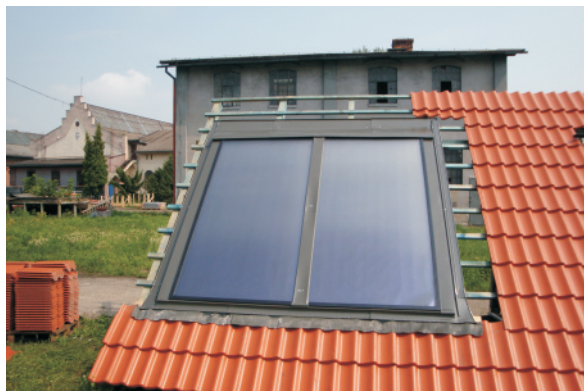
Verblechung festschrauben.
