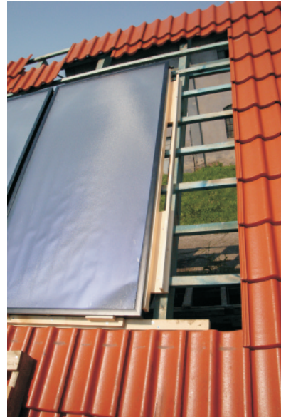
Äußere Rinnenhalter platzieren und festschrauben.
