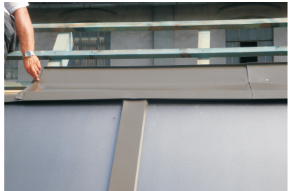
Verblechung festschrauben.
