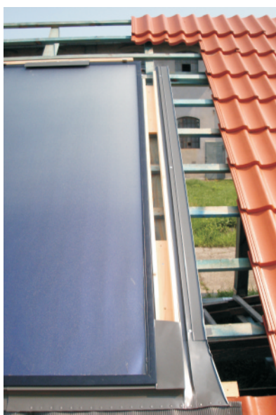
Seitliche Rinne befestigen und maskier leiste einschieben .
