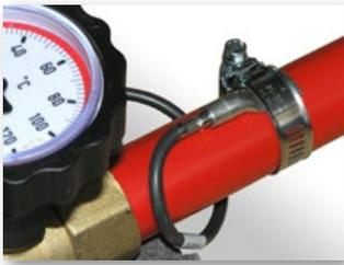
Abb 5: Verbindung des Rohranlegefühlers mit der Vorlaufleitung
