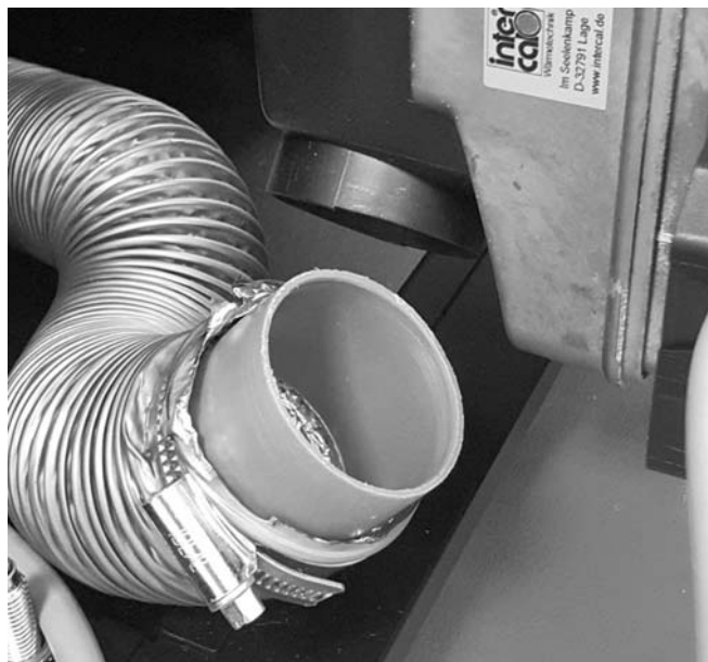
Abb. 13: Zuluftschlauch mit 50 mm Anschluss-Stück
