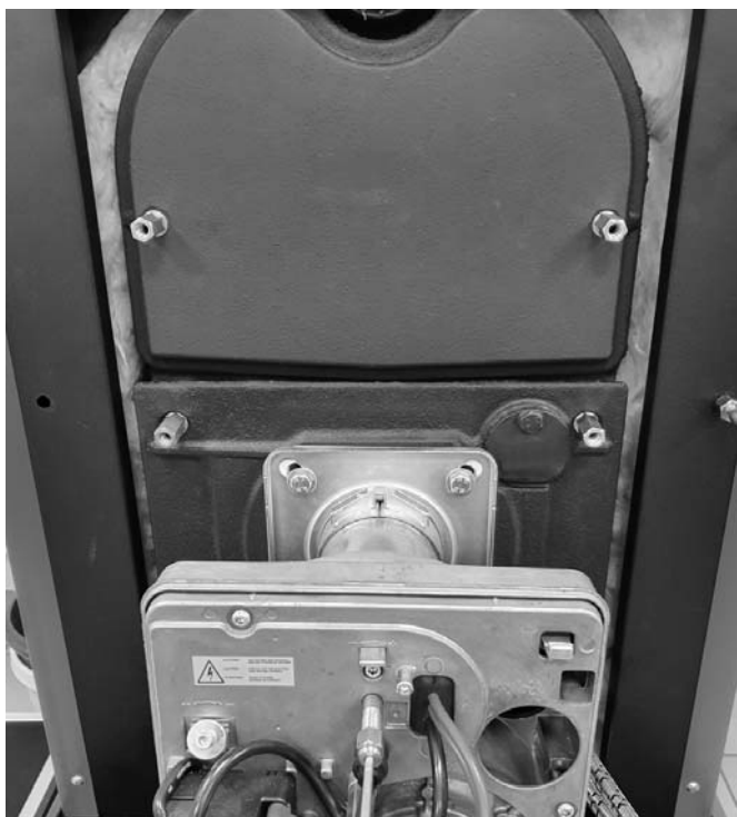
Abb. 84: Obere und untere Kesseltür
