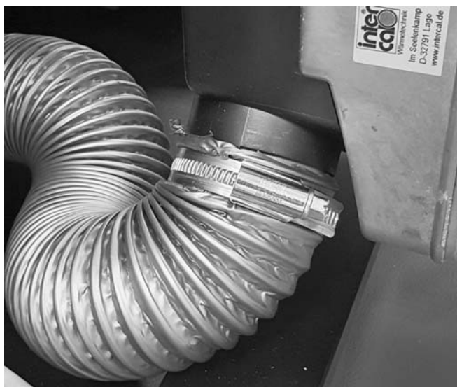
Abb. 14: Zuluftschlauch mit 50 mm Anschluss-Stück
