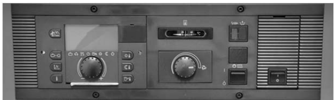
Abb. 35: Montierte THETA+ im Kessel-Grundschaftfeld.
