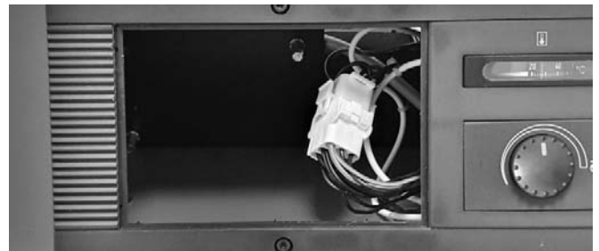
Abb. 105: Aufgesteckter Brückenstecker.
