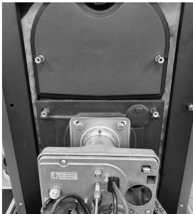
Abb. 84: Obere und untere Kesseltür
