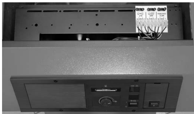
Abb. 27: Kessel-Grundschaltfeld ohne Regelung und Montagebereich für Anschluss-Klemmbrett
