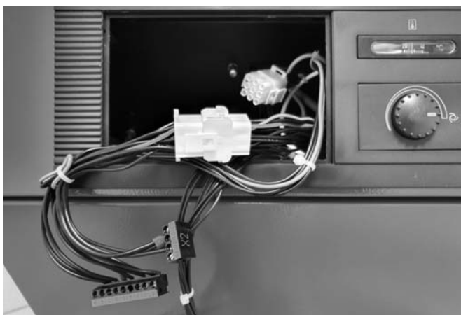
Abb. 104: Getrennte Anschlussstecker für den Regler.
