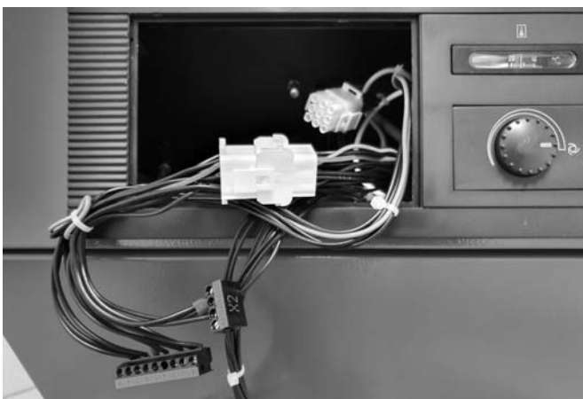
Abb. 104: Getrennte Anschlussstecker für den Regler.
