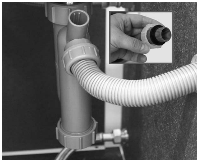
Abb. 16: Montage des Kondensatschlauchs
