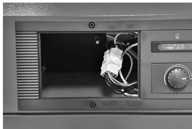
Abb. 29: Offener Reglerschacht mit Steckverbindung für den Regler-Kabelbaum.
