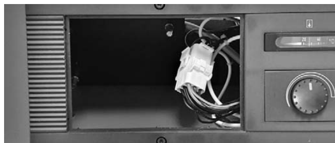
Abb. 105: Aufgesteckter Brückenstecker.
