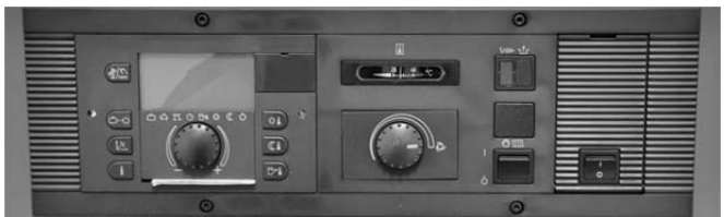
Abb. 35: Montierte THETA+ im Kessel-Grundschaftfeld.
