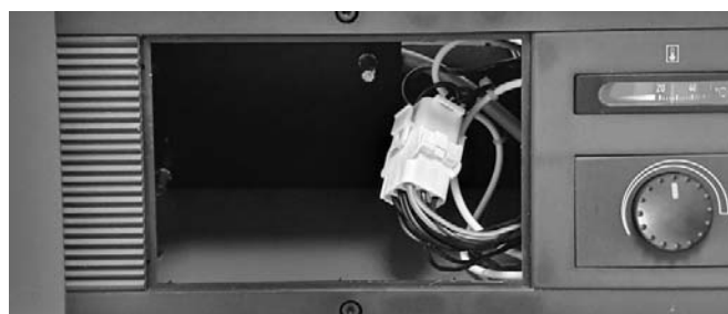
Abb. 105: Aufgesteckter Brückenstecker.
