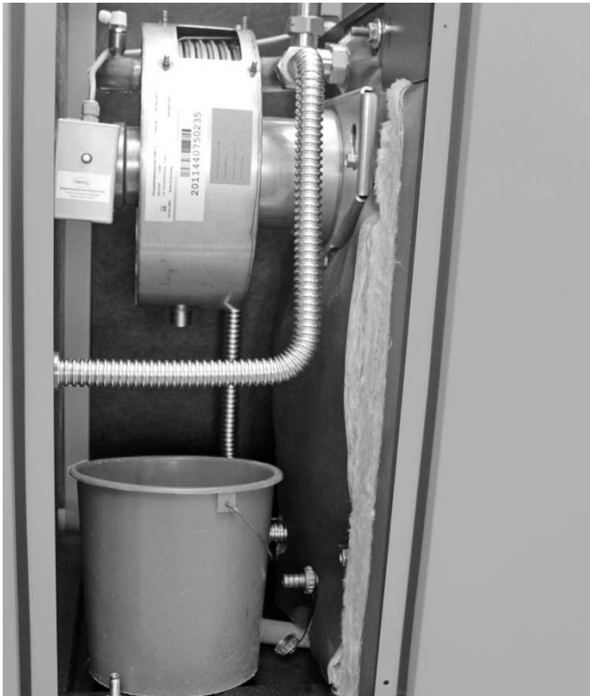
Abb. 89: Zur Reinigung vorbereiteter RWT
