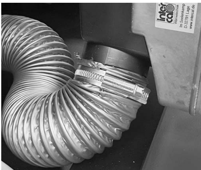
Abb. 14: Zuluftschlauch mit 50 mm Anschluss-Stück
