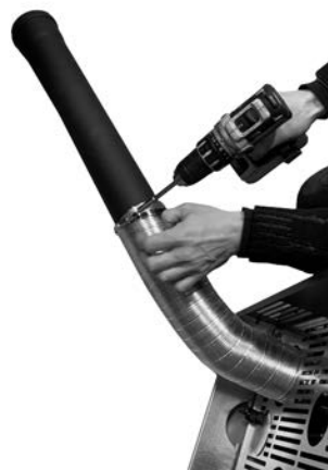
Fig. 61 - Rohr D. 80 mm anschließen
