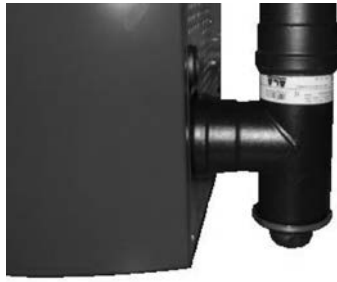
Fig. 71 - Reinigung des Rauchgaskanals
