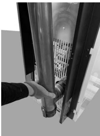
Fig. 41 - Rohr Durchm. 80 mm einstecken
