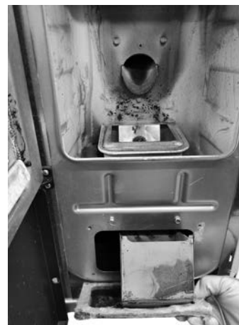
Fig. 73 - Den Inspektionsstopfen entfernen
