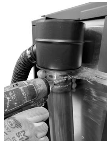
Fig. 48 - Mit Schelle sichern
