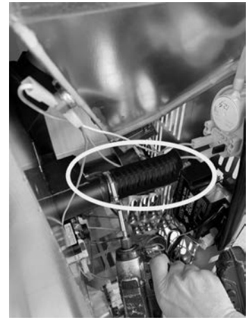
Fig. 51 - Schlauch anschließen
