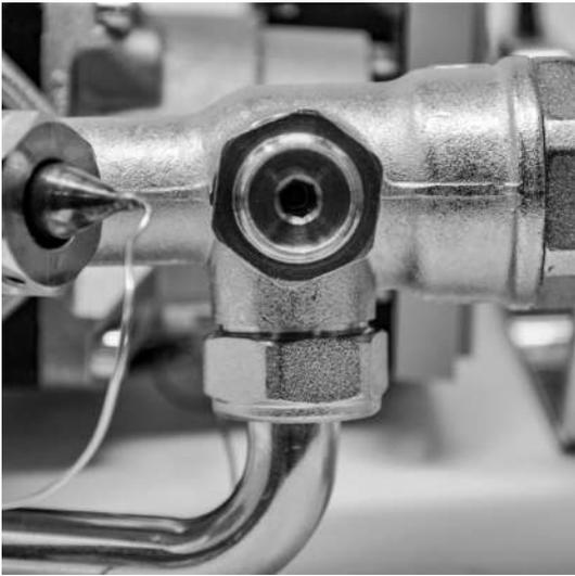
Die ordnungsgemäße Einstellung und der optimale Abgleich des Kreises erfolgt über die Rücklaufverschraubung am Anschluss der Bypass-Leitung für das Rücklaufwasser des Flächensystems in die Rücklaufleitung zum Kessel der Anlage. Die Einstellung erfolgt mithilfe eines Inbusschlüssels 5 mm.
