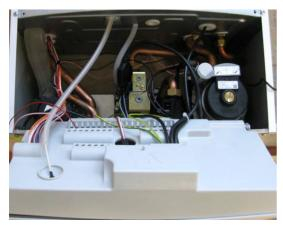
c) Metall-/Erdungsplatte wie abgebildet ankleben (das Erdungskabel muss an einen freien Erdungslasche der Kesselplatine angeschlossen werden)
