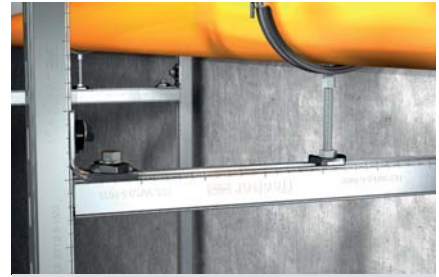
Rohrbefestigung auf Rahmenkonstruktion
