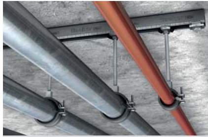
Rohrbefestigung an Montagewise
