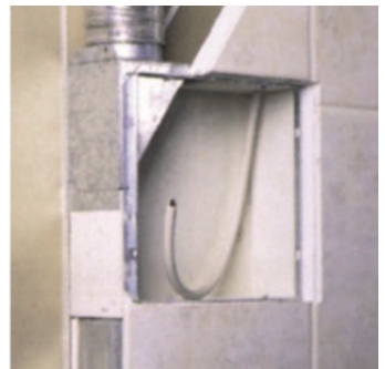
Unterputzgehäuse U in Trockenbauwand
