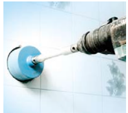
Kernbohrung in der Wand
