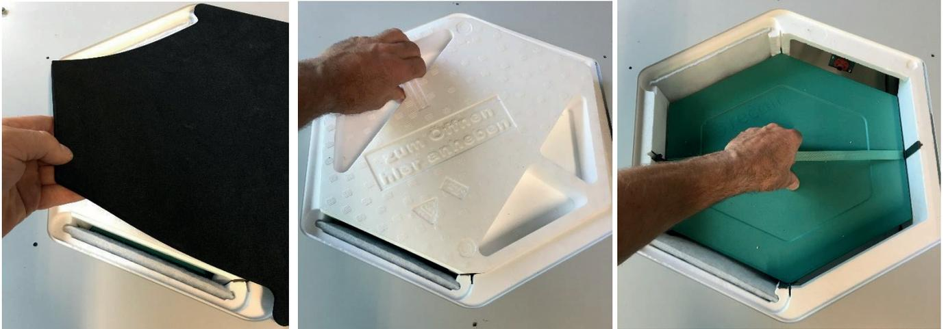
Nun den Wärmetauscher wieder vorsichtig in das Gerät einschieben. Hierbei besonders auf die obere und untere Führungsnut achten. Setzen sie den Bypass mit der Metallschiene zuerst ein und klappen ihn in das Gerät. Im Anschluss an die Reinigungsarbeit setzen Sie die schwarze Dichtmatte mit der glatten Fläche Richtung grünen Wärmetauscher wieder ein und verschließen die Revisionsöffnung durch verschrauben mit den sechs Schrauben.
