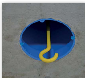
9 Montage als Deckendose, mit Klemmraum und Aufnahme für Deckenhaken.
