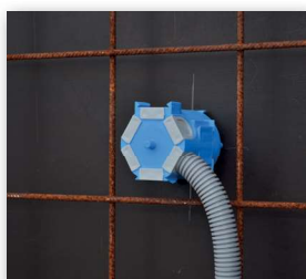
5 Fertig, absolut sichere Zugentlastung!
