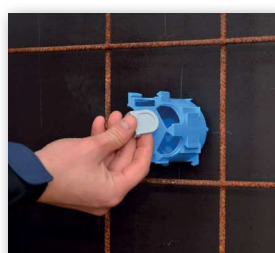
3 Nicht benötigte Öffnungen mit Schieber schließen.
