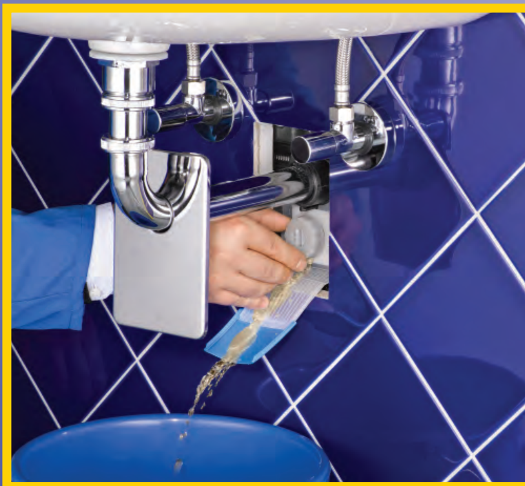
4. Öffnen der Verschlussmutter. Schmutzwasser kann über die Ablaufrutsche in einen Eimer geleitet werden. Verschmutztes Wasser dringt somit nicht mehr in die Vorwand.
